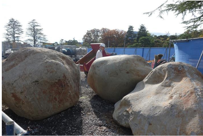
美術館工事現場から出てきた巨石3個
